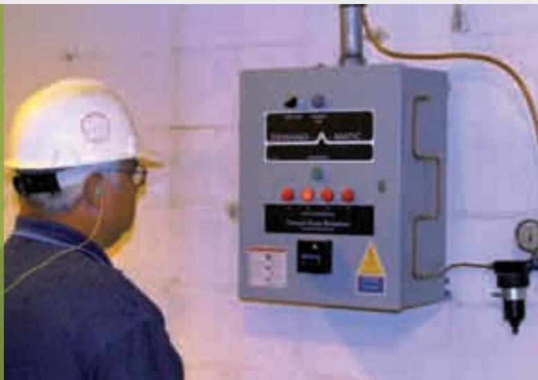
2. SISTEMA DI MONITORAGGIO ENERGIA UTILIZZATO PER IL CONTROLLO DELLE UTENZE ELETTRICHE
